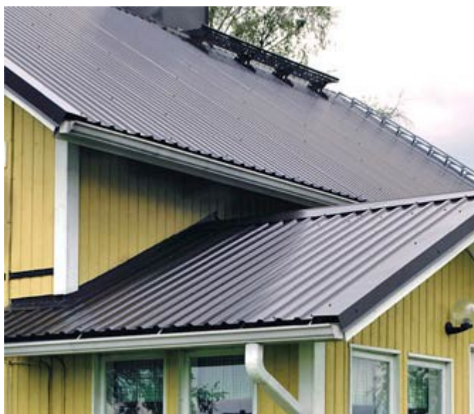
Рис.1. Карниз кровли из профнастила: H_g — нахлест горизонтальный; K_c — карнизный свес.
